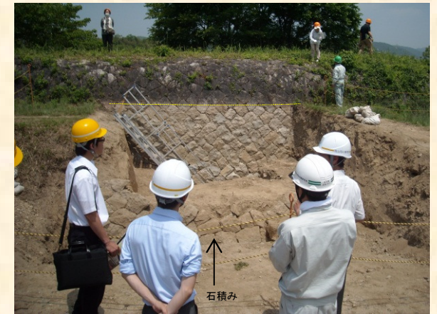
下流側の巻石部 (手前に新たに発見された石積みが見える)
