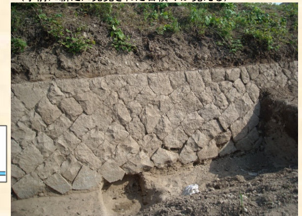
基礎まで確認された巻石の旭川側の石積み
