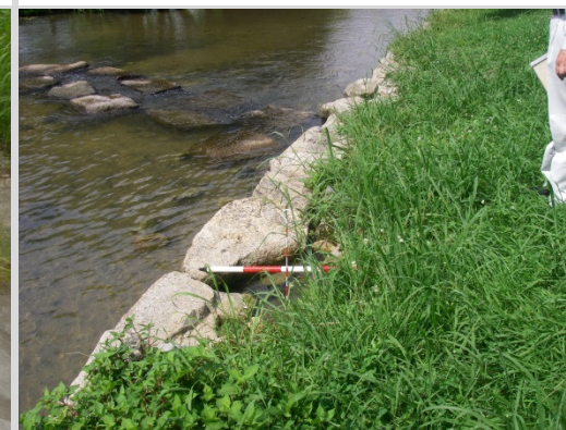
旭川 新大原橋付近広場
