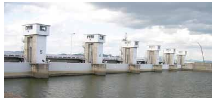
百間川河口水門
