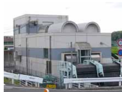
倉安川排水機場
