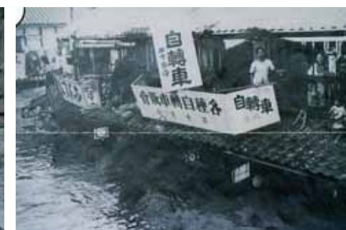
岡山市内の浸水状況
