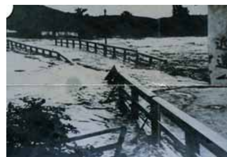
旭川の氾濫(岡山市)
