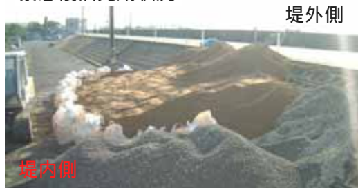
緊急復旧完成状況
