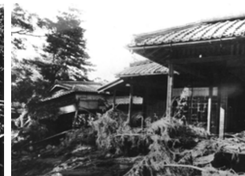
岡山後楽園内の被災状況
