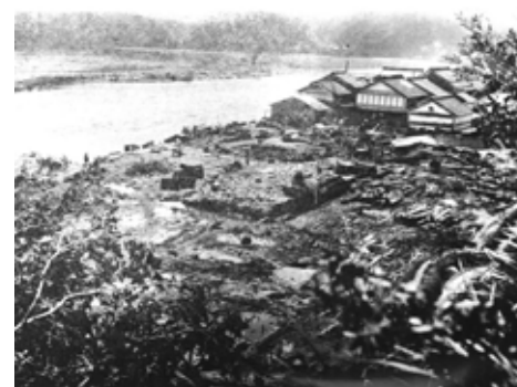
中流部の被災状況(真庭市)
