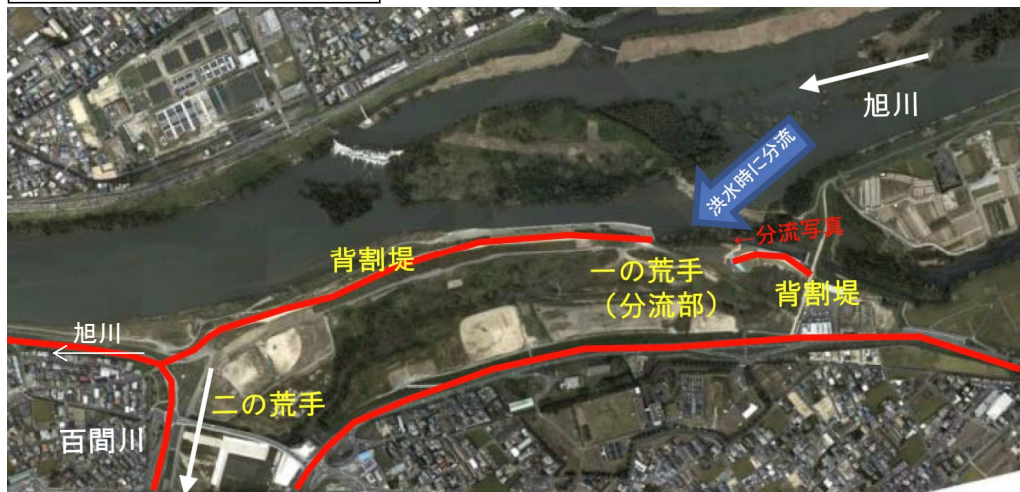
旭川放水路(百間川) 分流部
