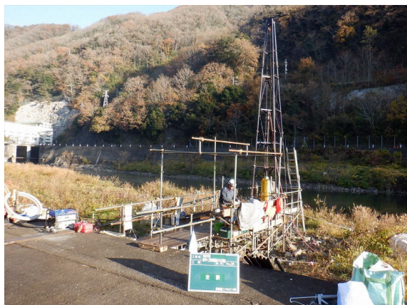
地質調査状況
