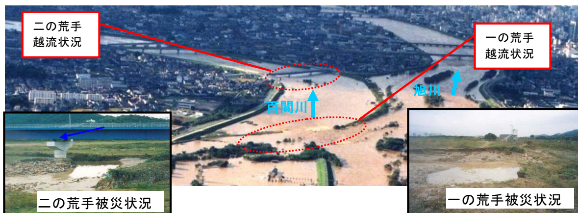
平成10年10月洪水による百間川への分流状況と一の荒手・二の荒手の被災状況
