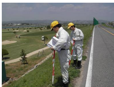
堤防点検の実施状況
