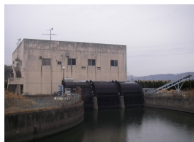
排水機場（庄内川排水機場）
