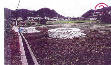
平成10年10月洪水時の基盤漏水 旭川16k400付近
