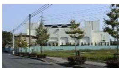
平井排水機場
