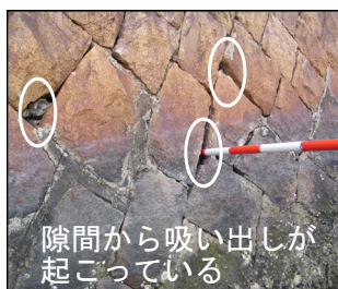
河口部の護岸状況
