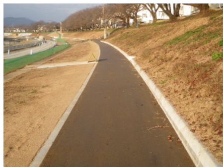
遊歩道の整備
