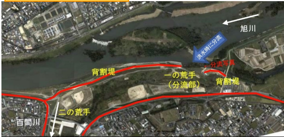
旭川放水路(百間川) 分流部
