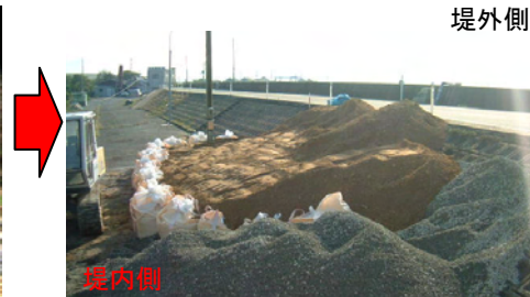
緊急復旧完成状況 平成16年8月高潮の状況 (岡山県管理海岸堤防被災状況)
