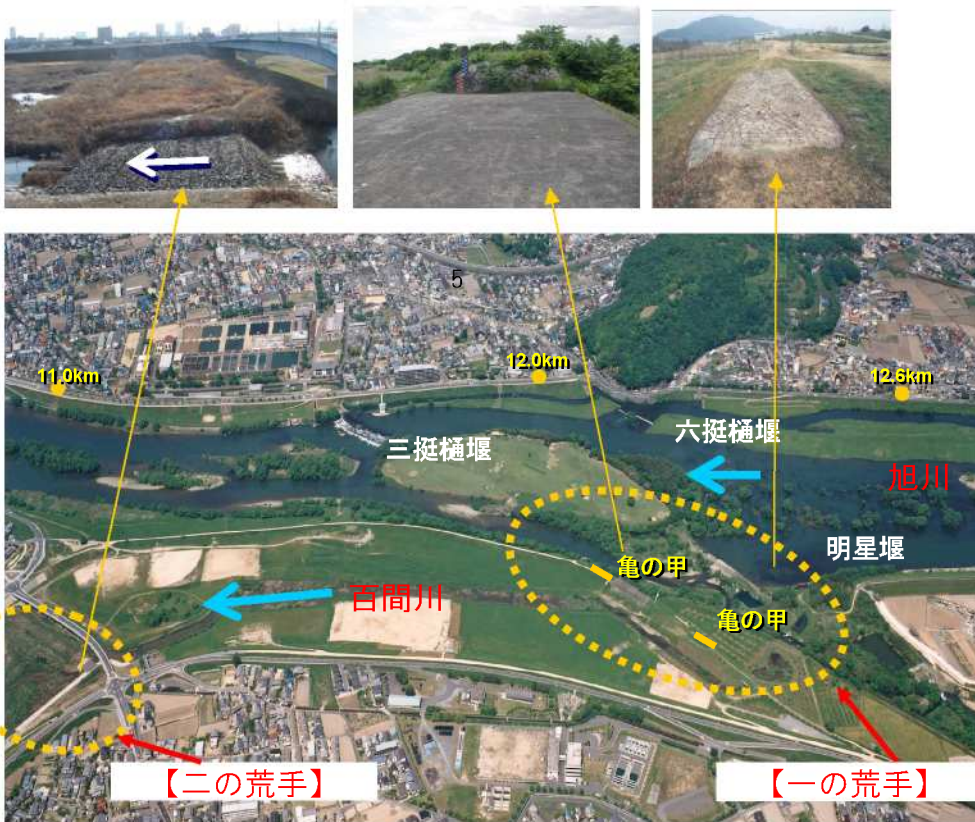
【分流部越流堤区間】
