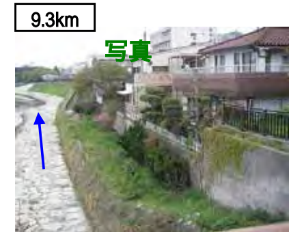
河岸沿いの低い位置に家屋が立地している
