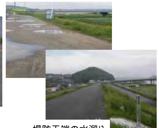
堤防天端の水溜り舗装状況
