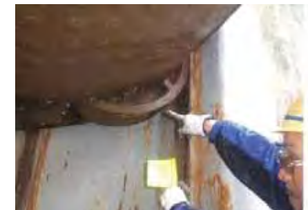
百間川河口水門点検状況
