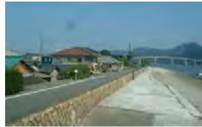
高潮区間は概ね既往最高潮位程度の高さは確保出来ている。(江並地先のパラペットと近接家屋の状況)
