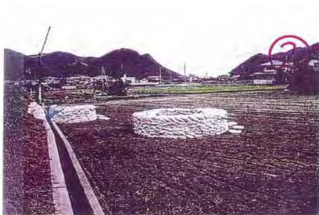
H10.10基盤漏水 旭川16k400付近
