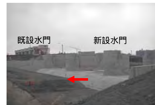
堰柱完成状況
