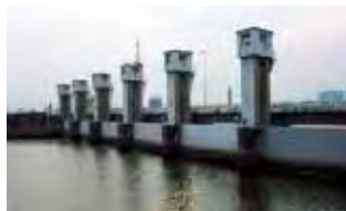
百間川河口水門の改築
