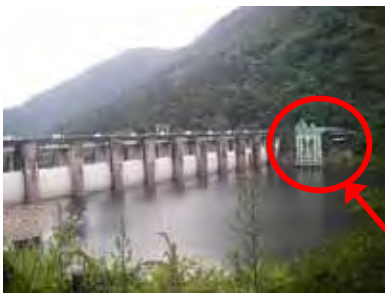
旭川ダム再開発によって建設された取水塔
