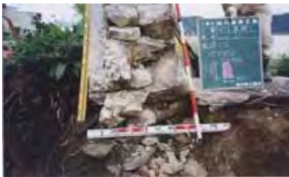
陸開門施工時にパラペットを取壊した時の状況
