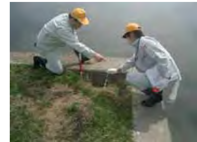
護岸点検状況
