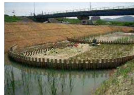
新田浄化施設 (礫間接触酸化 + 植生浄化)
