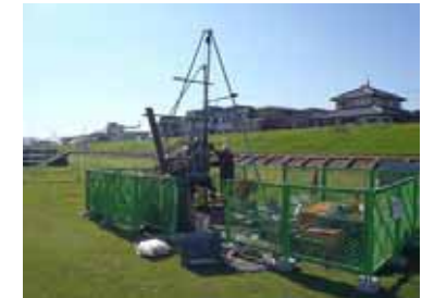
堤防の耐震点検のためのボーリング調査状況
