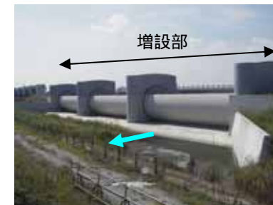
【増設された河口水門の状況】
