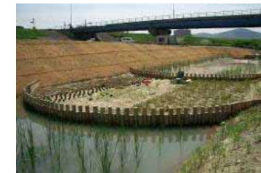
百間川新田浄化施設
