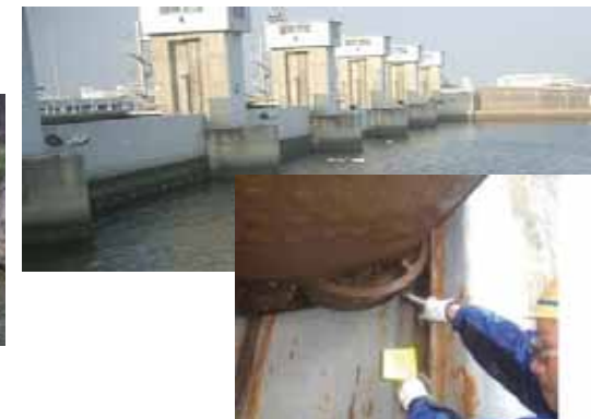
百間川河口水門点検状況
