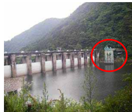
旭川ダム再開発によって建設された取水塔
