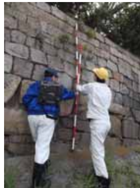
護岸点検状況
