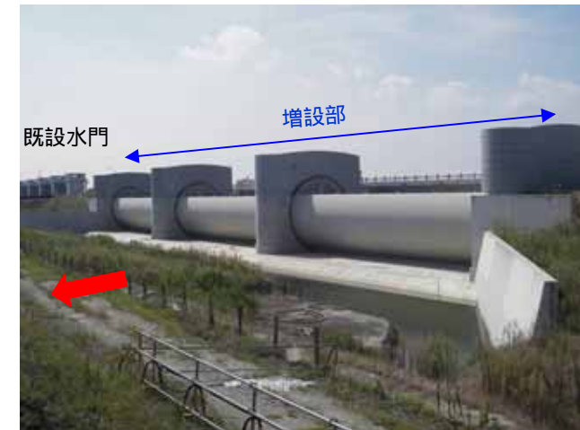
堰柱・ゲート完成状況
