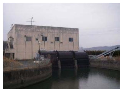
庄内川排水機場
