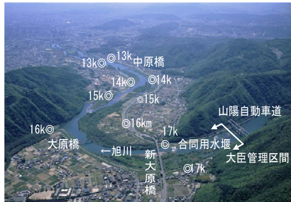
旭川中流地区の樹木繁茂状況
