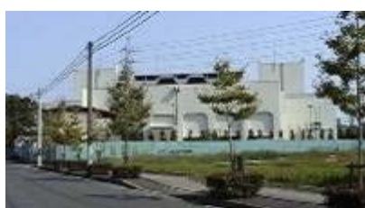
14 平井排水機場
