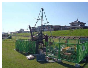
15 堤防の耐震点検の 16 ボーリング調査状況
