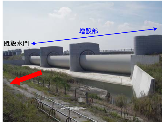
増設部の堰柱・ゲート完成状況
