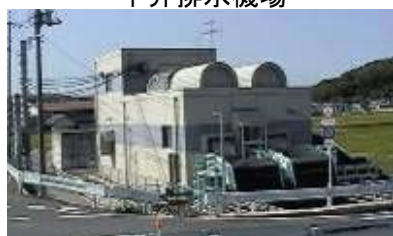
19 倉安川排水機場
