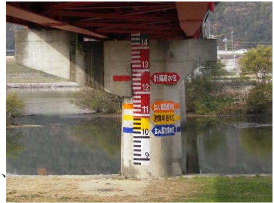
量水標（中原橋）
