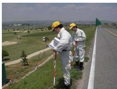
堤防点検の実施状況
