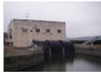
庄内川排水機場
