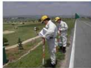
堤防点検の実施状況
