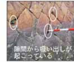
河口部の護岸状況
