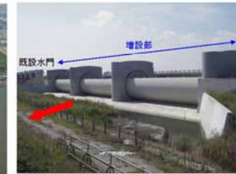
増設部の堰柱・ゲート完成状況
