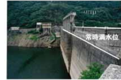
湯原ダムの貯水状況(平成6年)
