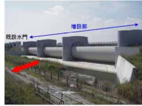
増設部の堰柱・ゲート完成状況
