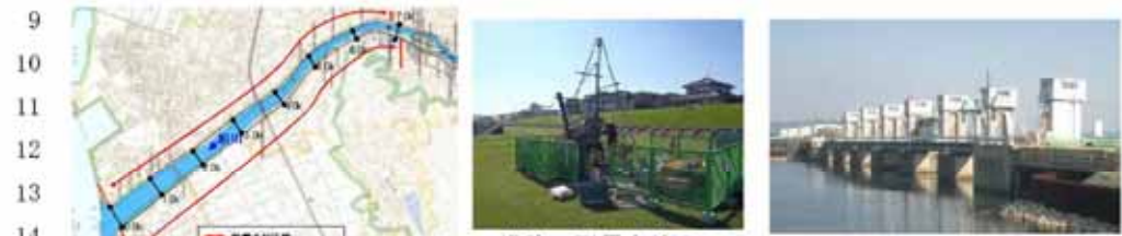
15 図 5.1.11 堤防耐震点検区間 堤防の耐震点検のボーリング調査状況 既設百間川河口水門
