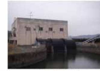
庄内川排水機場
