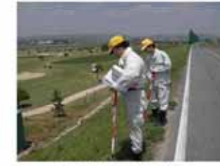
堤防点検の実施状況
