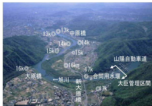
旭川中流地区の樹木繁茂状況
