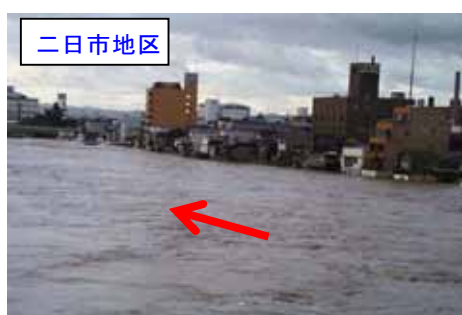
平成10年10月洪水の状況
