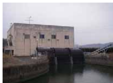
庄内川排水機場
