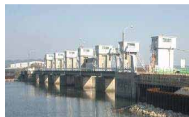
既設百間川河口水門
