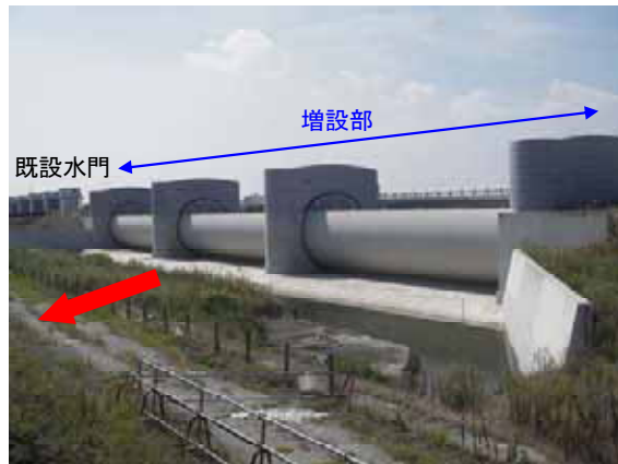
増設部の堰柱・ゲート完成状況
