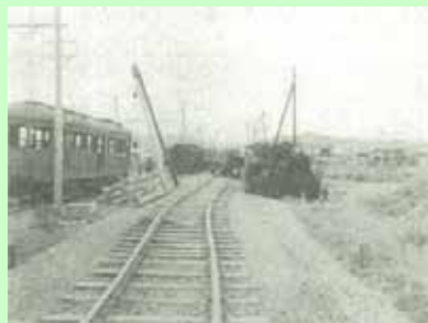
折れ曲がった線路と倒れた列車
