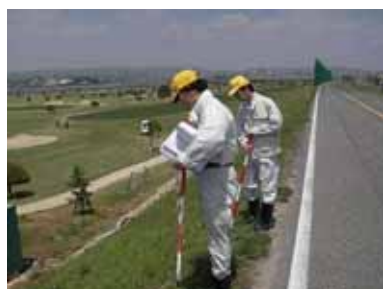
堤防点検の実施状況
