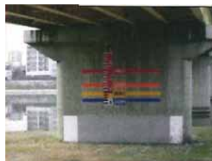
水位表示板(量水標)の事例
