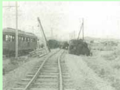
折れ曲がった線路と倒れた列車
