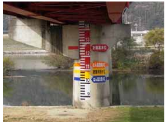
量水標（中原橋）
