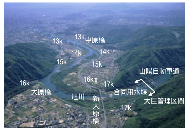
旭川中流地区の樹木繁茂状況
