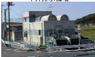
倉安川排水機場
