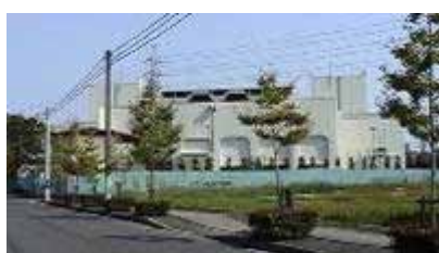
平井排水機場
