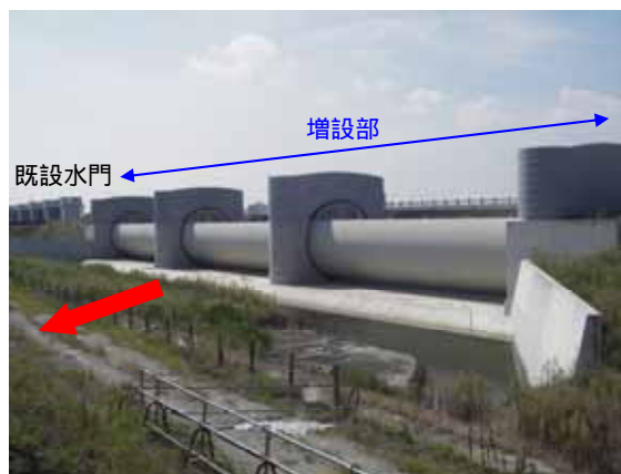
増設部の堰柱・ゲート完成状況
