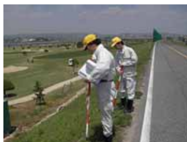
堤防点検の実施状況
