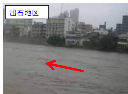
平成23年9月洪水の状況
