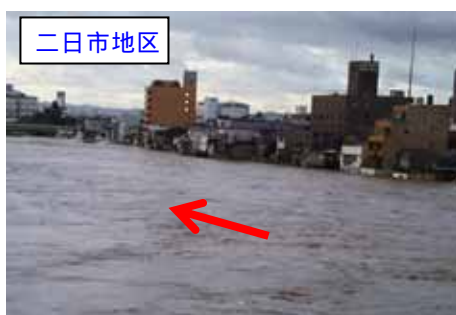
平成10年10月洪水の状況
