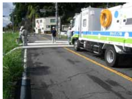
平成23年9月台風12号 排水ポンプ車出動状況
