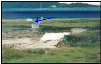
二の荒手被災状況
