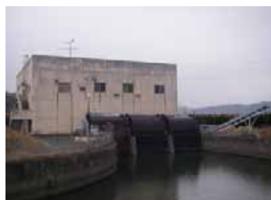
庄内川排水機場
