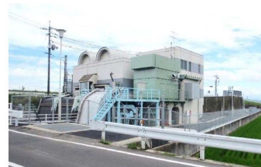
倉安川排水機場（平成11年整備）
