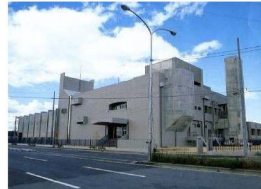
平井排水機場（昭和54年整備）
