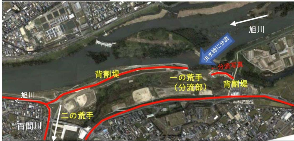
旭川放水路(百間川) 分流部
