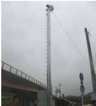
CCTV カメラの設置
