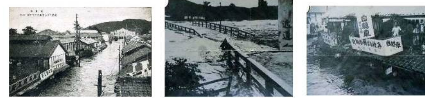
位置：岡山市内 旭川の被災状況(昭和9年9月洪水)岡山市松浦氏提供
