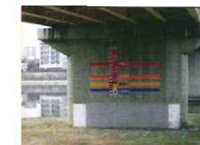
水位表示板（量水標）の事例
