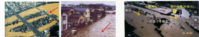
位置：岡山市内（東西中島地区） 位置：岡山市内（分流地点と中原地区） 旭川の被災状況(平成10年10月洪水)
