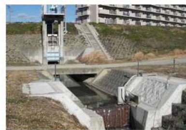
浄化施設を設置した「藤原樋門」
