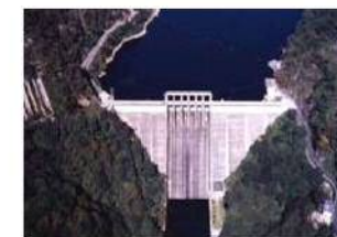
湯原ダム（管理者：岡山県）
