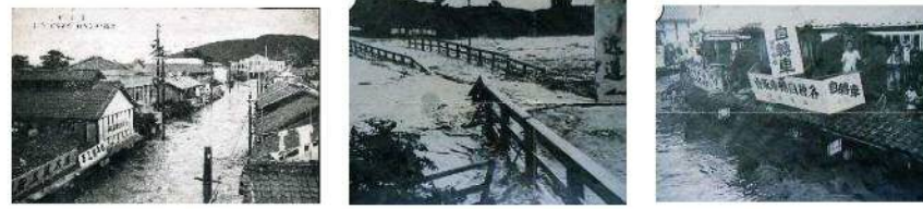
位置：岡山市内 旭川の被災状況(昭和9年9月洪水)岡山市松浦氏提供
