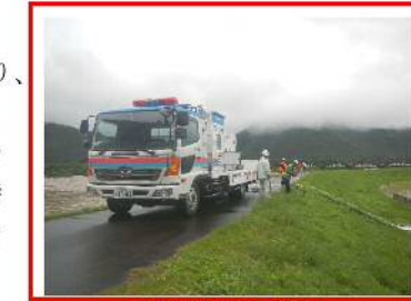
平成30年7月豪雨 排水ポンプ車出動状況
