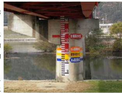
量水標（中原橋）
