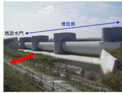
増設部の堰柱・ゲート完成状況
