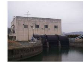
排水機場（庄内川排水機場）
