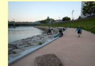
河川管理用通路（旭川おしろみち）
