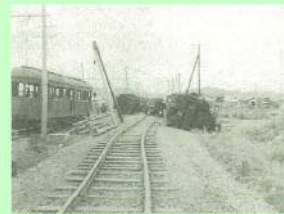
折れ曲がった線路と倒れた列車
