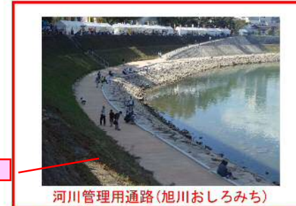
河川管理用通路 (旭川おしろみち)
