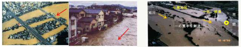
位置：岡山市内（東西中島地区） 位置：岡山市内（分流地点と中原地区） 旭川の被災状況(平成10年10月洪水)
