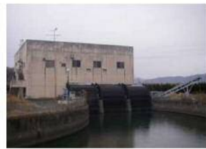
庄内川排水機場
