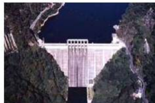
湯原ダム（管理者：岡山県）
