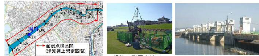
図 5.1.11 堤防耐震点検区間 堤防の耐震点検のボーリング調査状況 既設百間川河口水門(昭和門)
