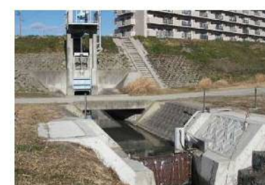
浄化施設を設置した「藤原樋門」
