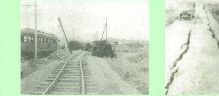
折れ曲がった線路と倒れた列車
