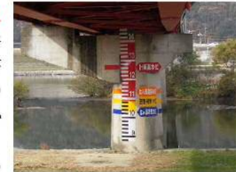
量水標（中原橋）
