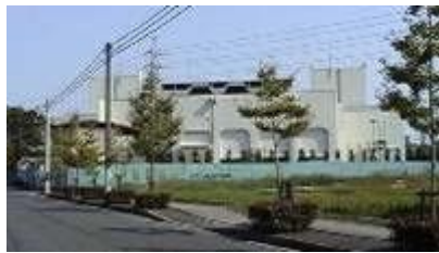
平井排水機場
