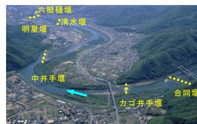
河道内に多く存在する固定堰
