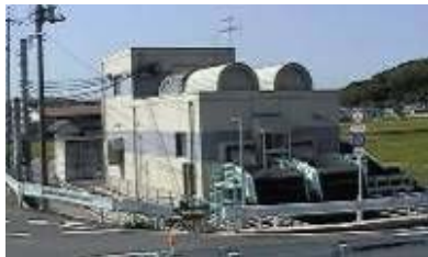
倉安川排水機場
