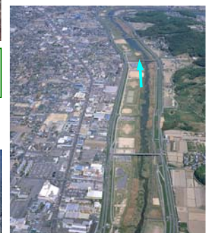
市街化が進む沿川と高度な高水敷利用
