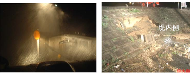
H16.8 岡山県管理区間の海岸堤防の被災状況
