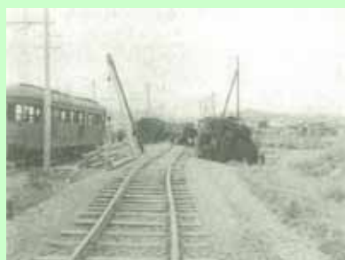
折れ曲がった線路と倒れた列車
