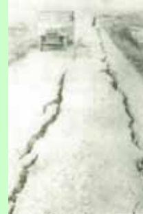
亀裂の入った堤防道路 （旧三蟠村付近）
