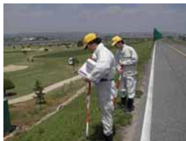
堤防点検の実施状況
