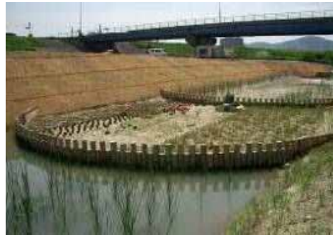
新田浄化施設
