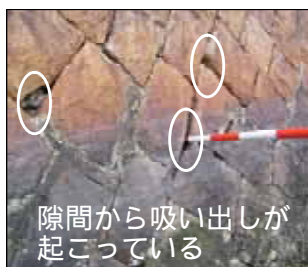
河口部の護岸状況
