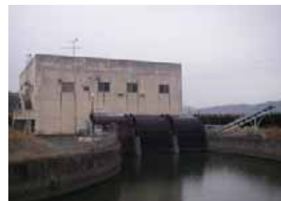
庄内川排水機場
