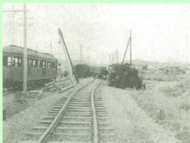
折れ曲がった線路と倒れた列車
