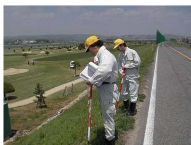
堤防点検の実施状況
