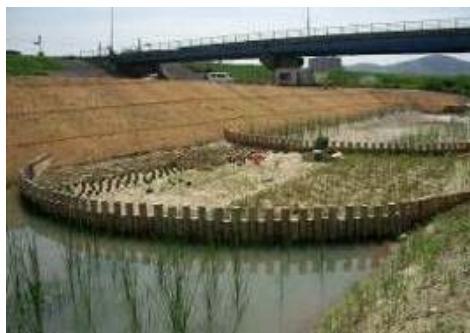
新田浄化施設
