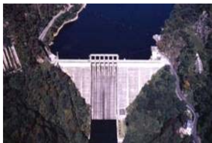
湯原ダム（管理者：岡山県）
