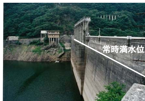
湯原ダムの貯水状況(平成6年)
