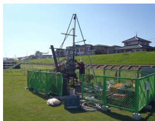
15 堤防の耐震点検の ボーリング調査状況
