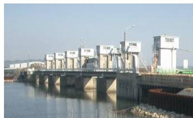
15 既設百間川河口水門
