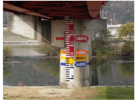
量水標（中原橋）
