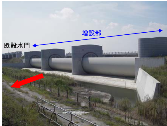
増設部の堰柱・ゲート完成状況
