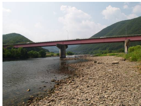
旭川におけるれき河原再生試験整備の状況 (大原箇所)
