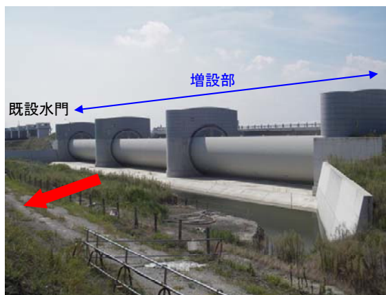
増設部の堰柱・ゲート完成状況
