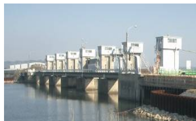
15 既設百間川河口水門
