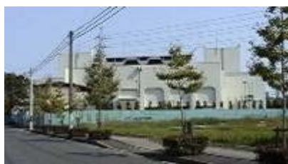
14 平井排水機場
