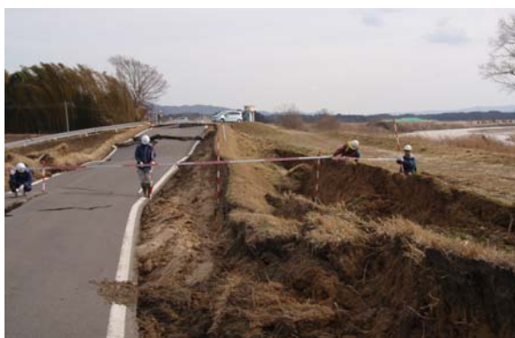
堤防沈下の事例（阿武隈川坂津田地区） 提供：東北地方整備局
