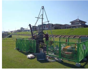
堤防の耐震点検のボーリング調査状況
