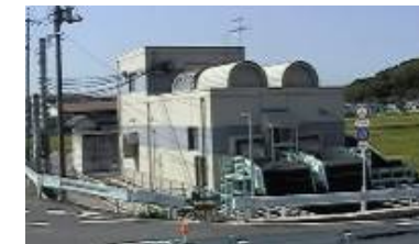
倉安川排水機場
