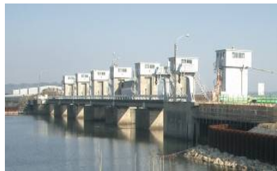
既設百間川河口水門
