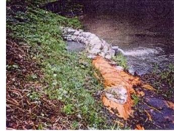
平成10年10月洪水時の堤体漏水
