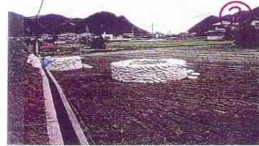
平成10年10月洪水時の基盤漏水
