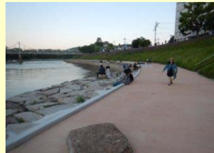
河川管理用通路（旭川おしろみち）
