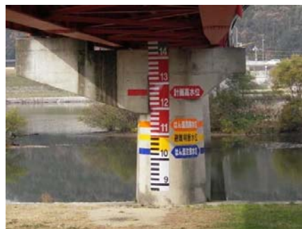
量水標（中原橋）
