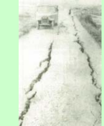
亀裂の入った堤防道路（旧三幡村付近）
