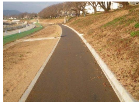
遊歩道の整備
