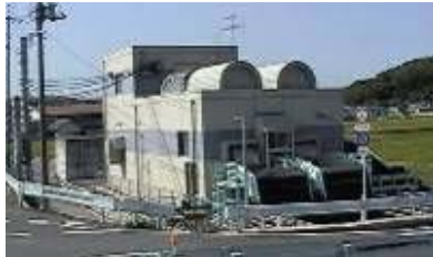
倉安川排水機場
