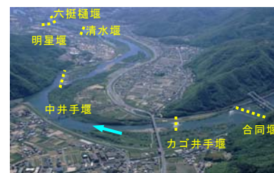
河道内に多く存在する固定堰
