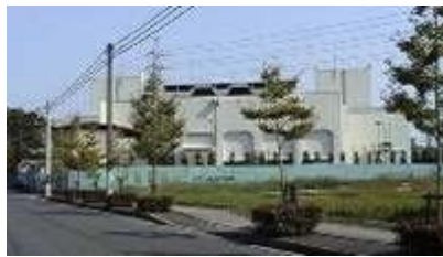
平井排水機場
