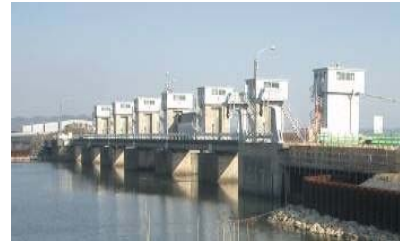
百間川河口水門(昭和 water 門)
