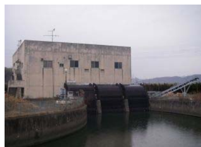
排水機場（庄内川排水機場）
