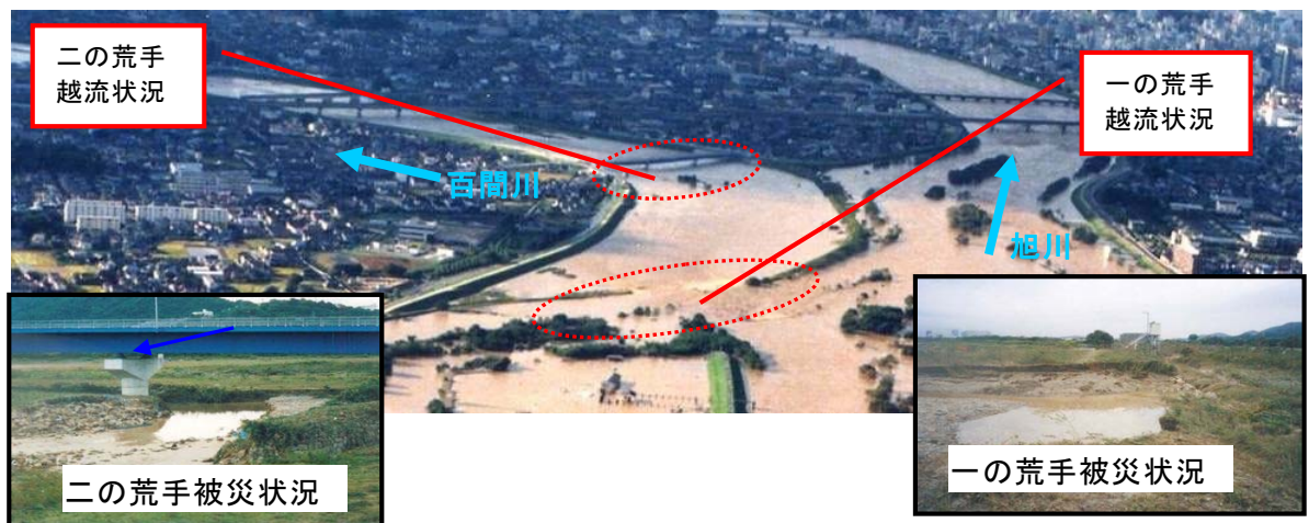
平成10年10月洪水による百間川への分流状況と一の荒手・二の荒手の被災状況
