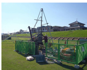
堤防の耐震点検のボーリング調査状況
