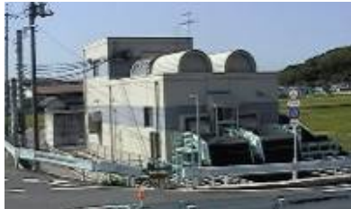
倉安川排水機場
