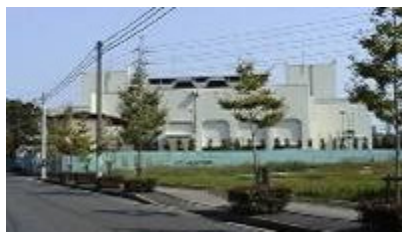
平井排水機場
