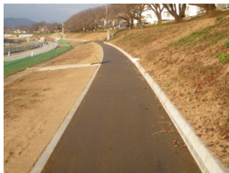
遊歩道の整備
