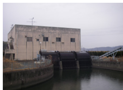
排水機場（庄内川排水機場）
