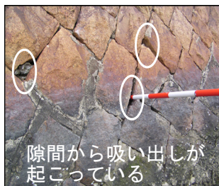
河口部の護岸状況
