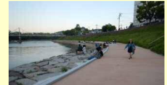
河川管理用通路（旭川おしろみち）
