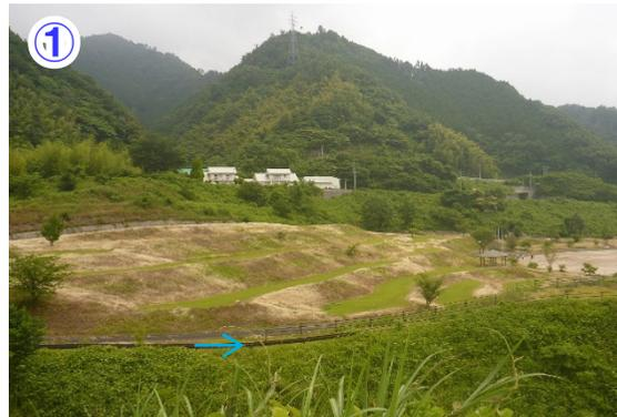
① 法面を地形に沿った棚田とした地形処理とし、一枚法面と比較して圧迫感が軽減される。
