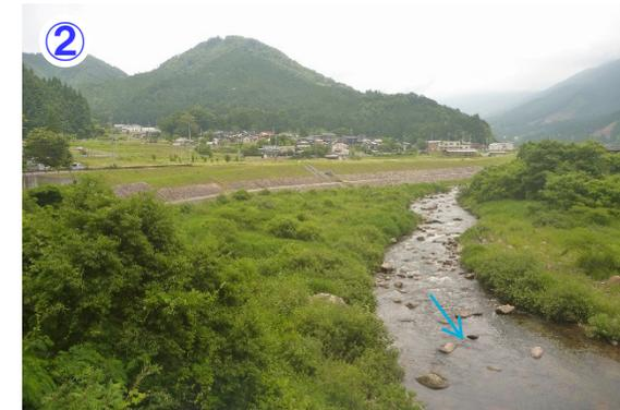
② 堤防法面は、全てを護岸とせず、上部には植生を施している。護岸部分も明度の低いものを採用し、周囲の景観になじむようにしている。
