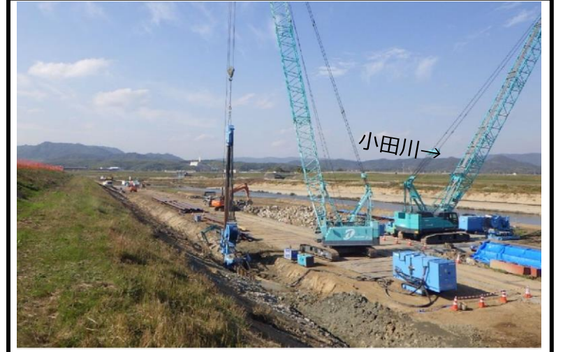
①川辺地区 堤防強化工事状況 (令和元年11月13日撮影)
