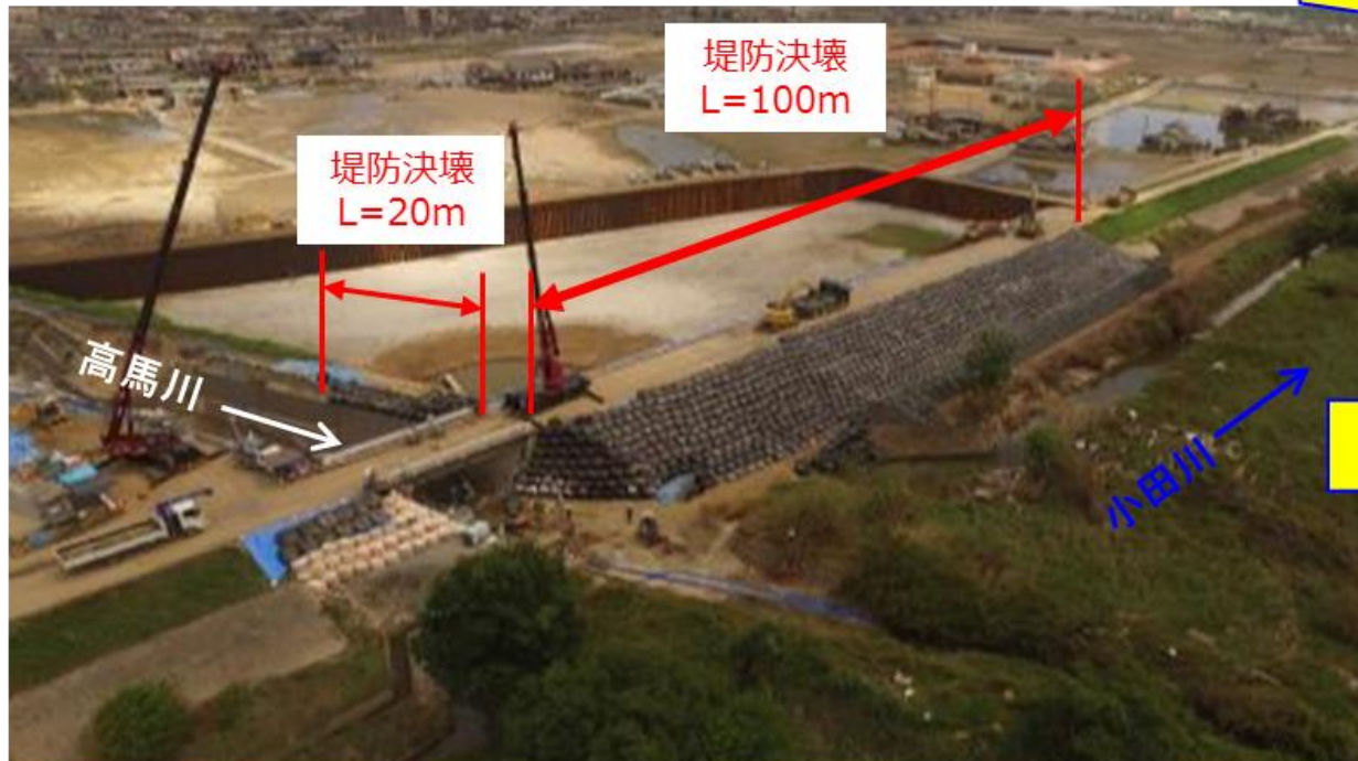
7月21日(土)10:00 応急復旧堤防 完成 7月21日(土)11:00頃撮影
