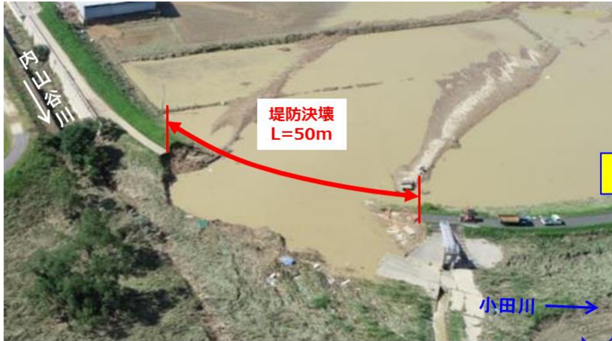
7月8日(日) 14:30に緊急対策工事に着手 7月8日(日) 15:00頃撮影
