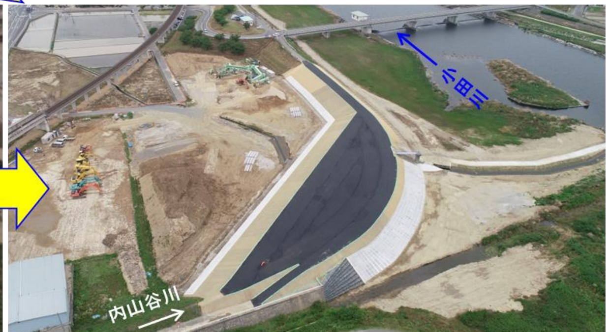
令和元年6月14日(金)完成
