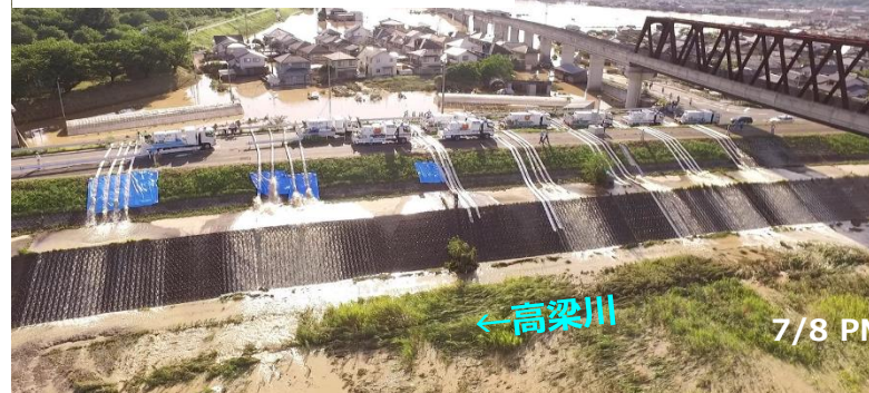
ポンプ車による排水作業状況
