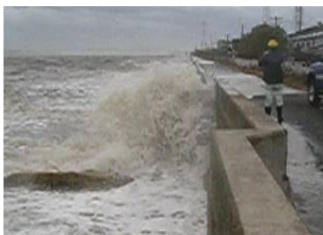
高梁川の高潮越波状況（平成16年台風16号） 位置：倉敷市玉島乙島地区
