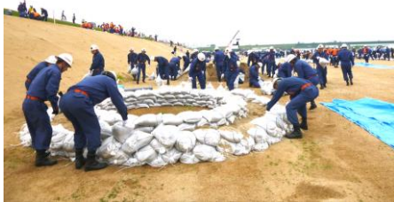
39 高梁川総合水防演習（平成28年5月28日）
