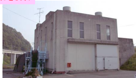
軽部排水機場（ポンプ場）
