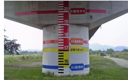
橋脚への量水標の設置状況 (高梁川)
