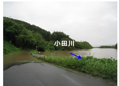
小田川付近の状況（平成23年9月洪水） 位置：倉敷市真備町川辺
