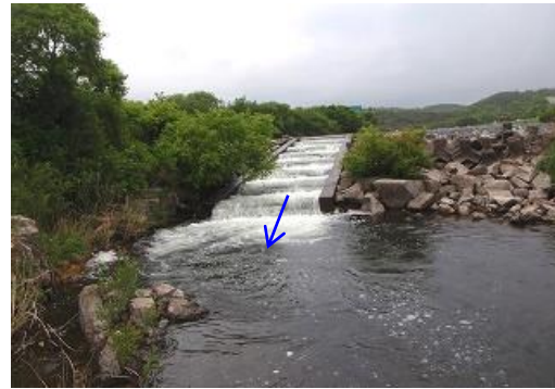
魚道現況（笠井堰）
