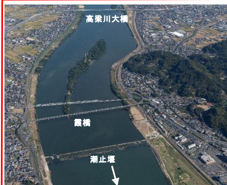
潮止堰上流の湛水区間
