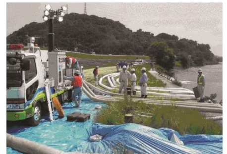
排水ポンプ車操作訓練（高梁川）
