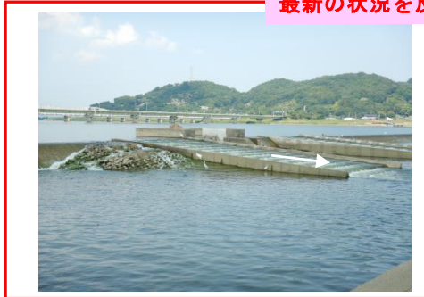
潮止堰の魚道の現状
