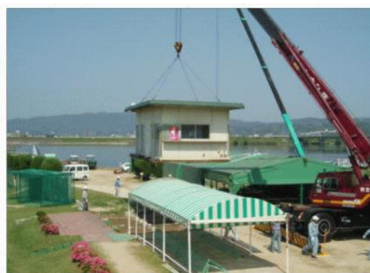
37 霞橋ゴルフ場上屋の撤去訓練
