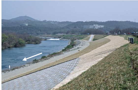
堤防補強の状況（高梁川酒津地区）
