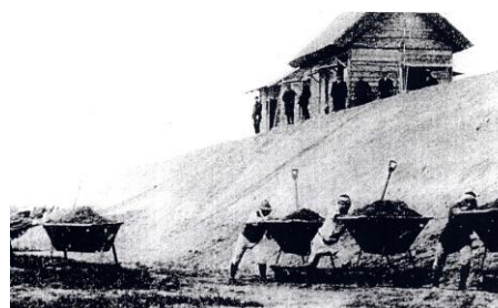
酒津付近の築堤工事（明治 44 年）
