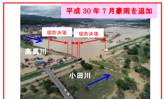
小田川の堤防決壊による浸水状況 （平成30年7月豪雨）
