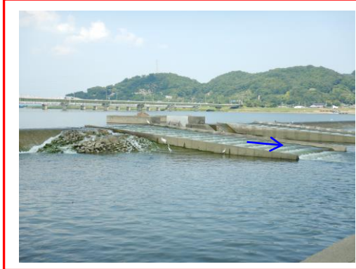
魚道現況（潮止堰：改良後）
