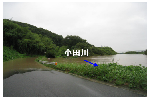
小田川付近の状況（平成23年9月洪水） 位置：倉敷市真備町川辺
