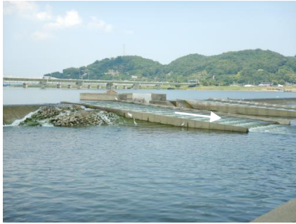
潮止堰の魚道の現状
