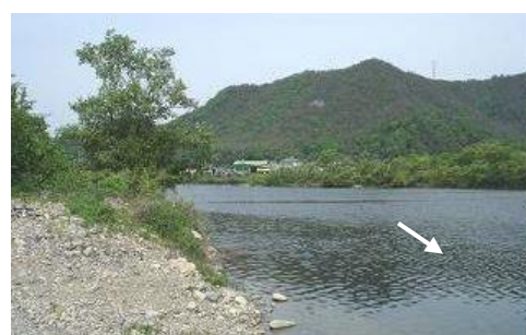
高梁川 高梁川合同堰（湛井堰） 上流の湛水区間 (大臣管理区間上流端の下流側)
