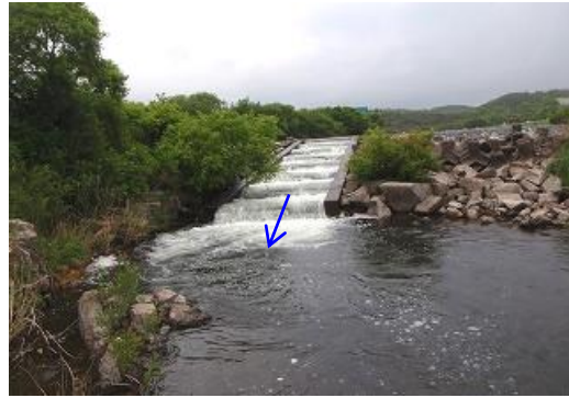
魚道現況（笠井堰）
