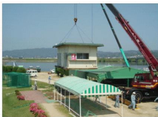
37 霞橋ゴルフ場上屋の撤去訓練
