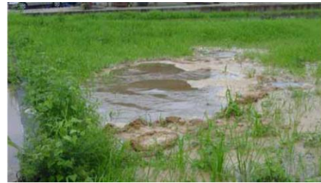
砂の噴出に伴う陥没の発生状況 (H18. 7 洪水、総社市清音地区) 洪水時に、堤防基盤からの漏水により、 堤防から離れた所で水と土砂が吹き出 したものです。
