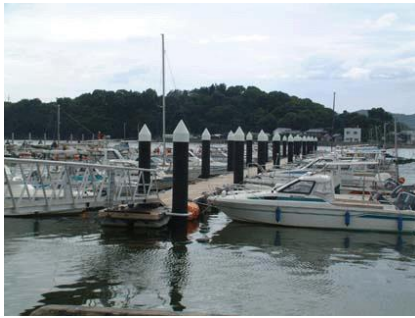
小型船舶係留施設（乙島西地区）
