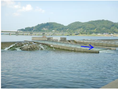
魚道現況（潮止堰：改良後）
