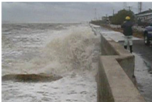
高梁川の高潮越波状況（平成16年台風16号） 位置：倉敷市玉島乙島地区
