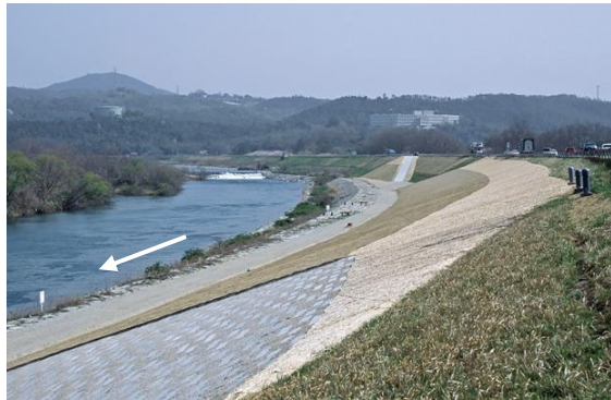
堤防補強の状況（高梁川酒津地区）
