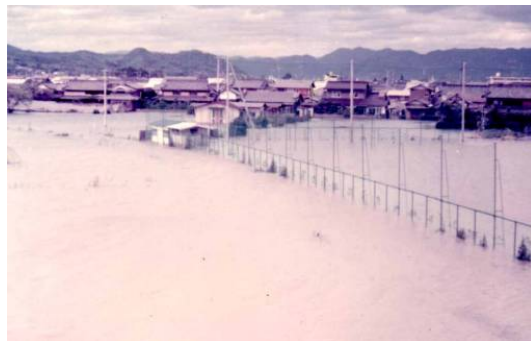
小田川の雨水出水（内水）氾濫状況（昭和51年9月洪水） 位置：倉敷市真備町川辺
