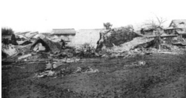
高梁川の家屋被災状況（明治26年10月洪水） 位置：倉敷市真備町川辺字辻尾 出典：岡山縣水害写真帖（明治26年）
