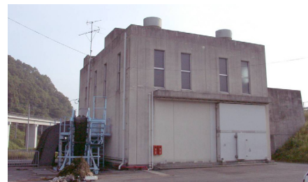
軽部排水機場（ポンプ場）
