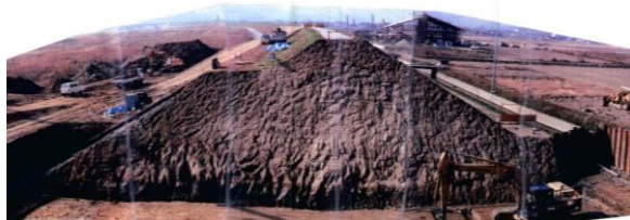
23 主に第一期改修に築造された小田川の堤防断面 24 (1 km 付近左岸)
