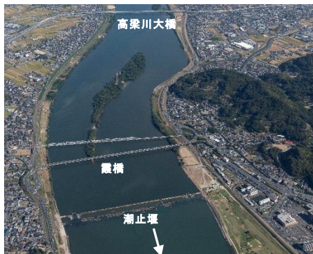
潮止堰上流の湛水区間
