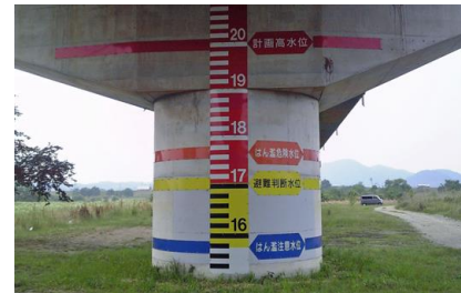
橋脚への量水標の設置状況 (高梁川)
