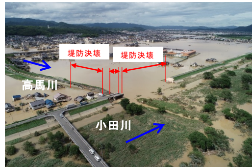
小田川の堤防決壊による浸水状況（平成30年7月豪雨）
