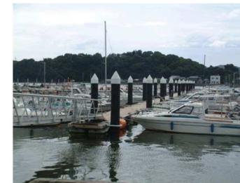
小型船舶係留施設(乙島西地区)
