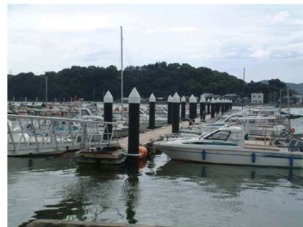
小型船舶係留施設(乙島西地区) (岡山県管理・収容94隻)
