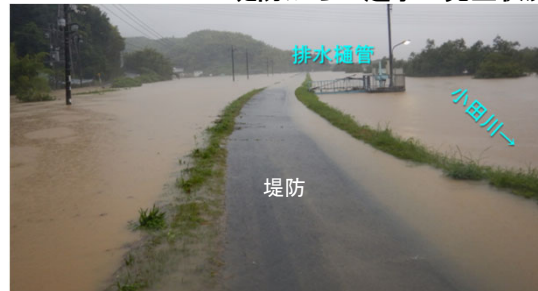
堤防からの越水の発生状況
