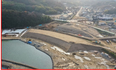
改良土を用いた築堤の施工状況
