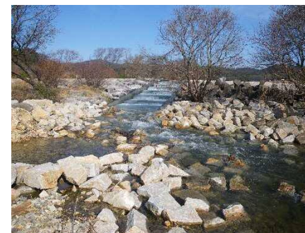
既設魚道を活用した周辺環境の改善状況 (魚道入口の落差解消等:倉敷市)
