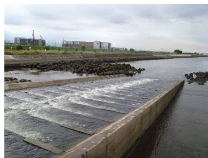
【改良後の1号魚道】
