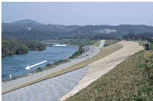
堤防補強の状況（高梁川酒津地区）
