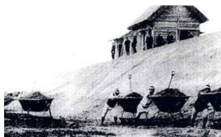
酒津付近の築堤工事（明治 44 年）
