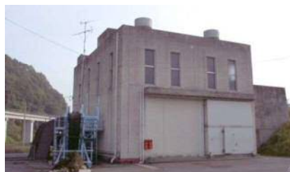
軽部排水機場（ポンプ場）
