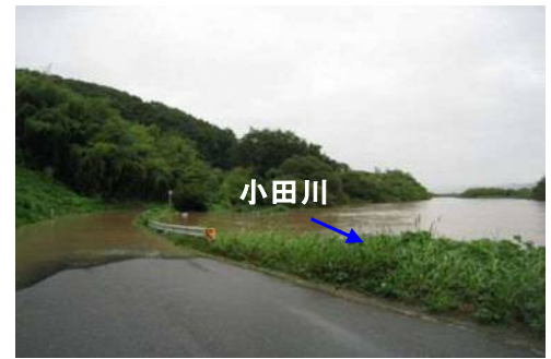
小田川付近の状況（平成23年9月洪水） 位置：倉敷市真備町川辺
