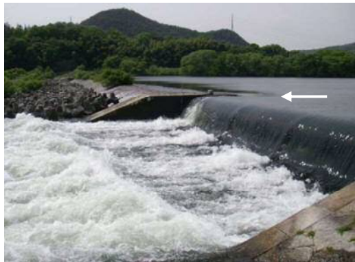
笠井堰（固定堰）
