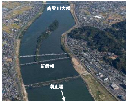
潮止堰上流の湛水区間
