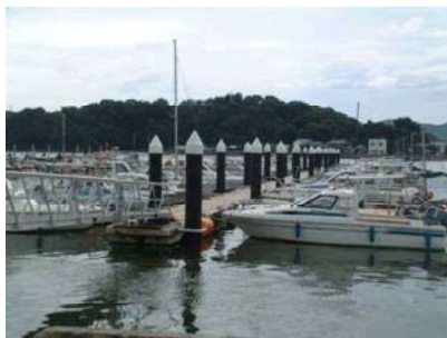
小型船舶係留施設（乙島西地区） （岡山県管理）
