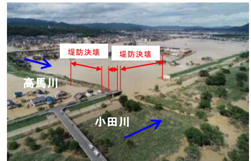
小田川の堤防決壊による浸水状況 （平成30年7月豪雨） 位置：倉敷市真備町
