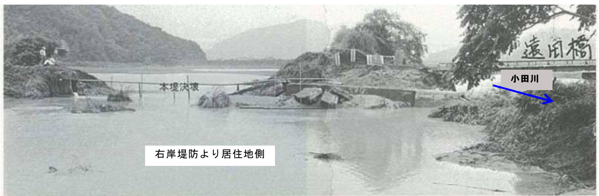
小田川の堤防決壊による浸水状況（昭和47年7月豪雨） 位置：倉敷市真備町遠田地区 出典：昭和47年豪雨災害誌（建設省）
