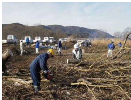
公募による樹木伐採状況
