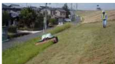
堤防の除草状況
