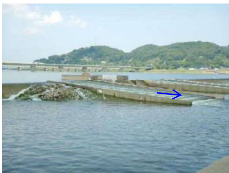
魚道現況（潮止堰：改良後）
