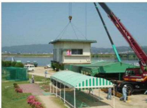
霞橋ゴルフ場上屋の撤去訓練
