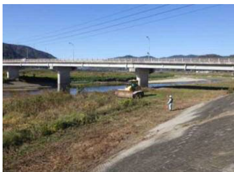
ブルドーザーによる草の踏み倒し
