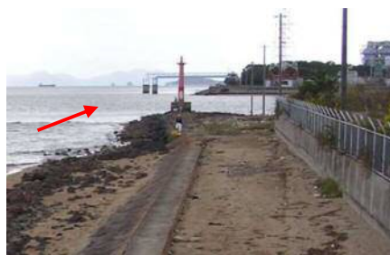
堤防の未整備区間の状況（高梁川河口付近）
