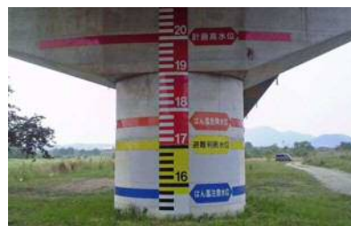
橋脚への量水標の設置状況 (高梁川)
