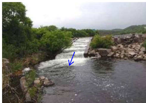
魚道現況（笠井堰）
