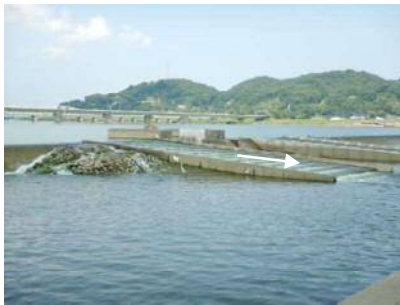
潮止堰の魚道の現状
