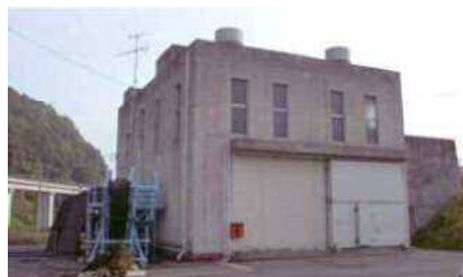
軽部排水機場（ポンプ場）
