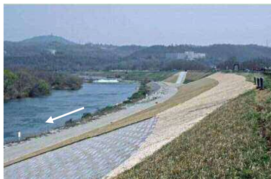
堤防補強の状況（高梁川酒津地区）
