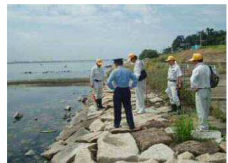
共同安全利用点検の状況（高梁川）
