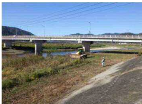
ブルドーザーによる草の踏み倒し
