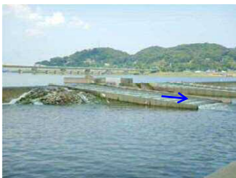
魚道現況（潮止堰：改良後）
