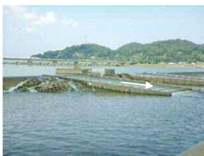
潮止堰の魚道の現状
