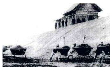
酒津付近の築堤工事（明治 44 年）
