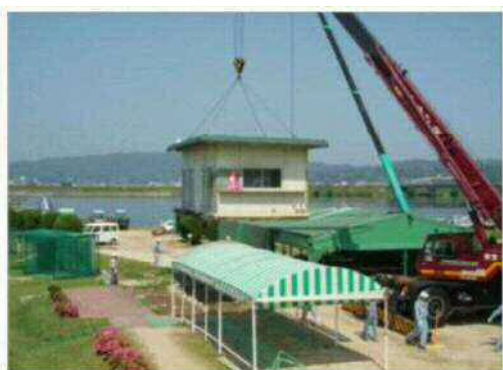
霞橋ゴルフ場上屋の撤去訓練
