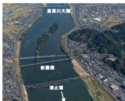
潮止堰上流の湛水区間
