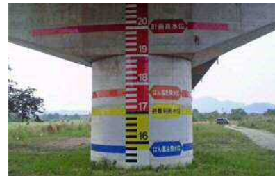
橋脚への量水標の設置状況 (高梁川)
