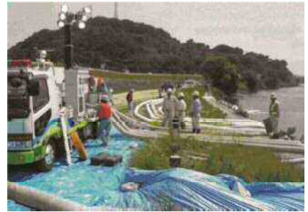
排水ポンプ車操作訓練（高梁川）
