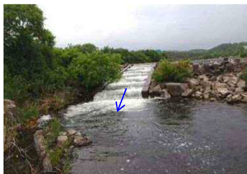
魚道現況（笠井堰）
