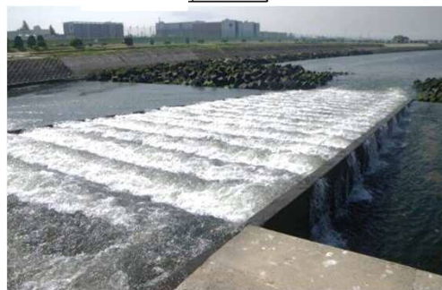
【改良前の1号魚道】
