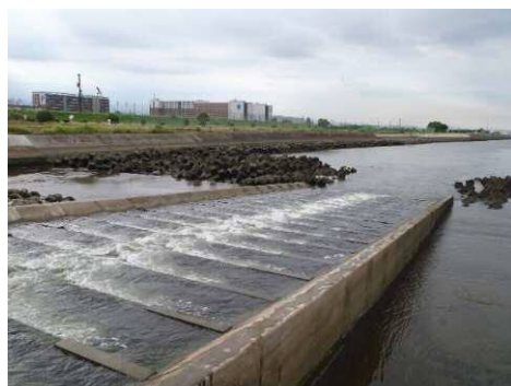
【改良後の1号魚道】
