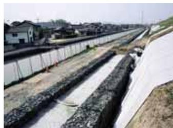
堤防補強におけるドレーン部の施工状況(高梁川10.2k東岸側、倉敷市酒津地区)
