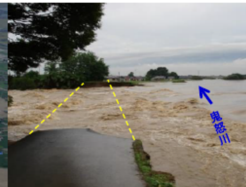
被災状況(拡大写真)
