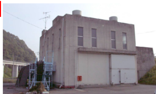
軽部排水機場(ポンプ場)
