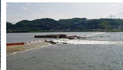
潮止堰の魚道の現状
