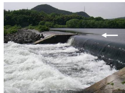
笠井堰(固定堰)
