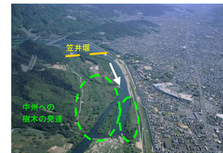
笠井堰付近の樹木の繁茂状況
