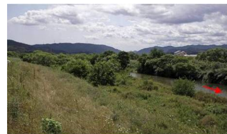
樹林化の現状(小田川矢形橋付近、H19年)
