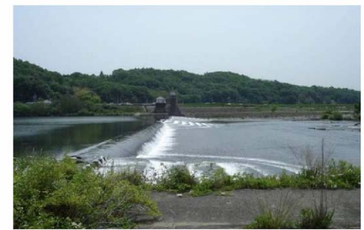
魚道現況(高梁川合同堰(湛井堰)の例)
