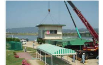
霞橋ゴルフ場上屋の撤去作業(高梁川)
