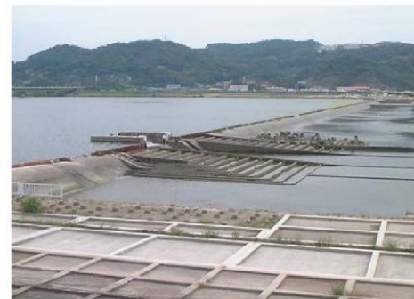
魚道現況(潮止堰の例)
