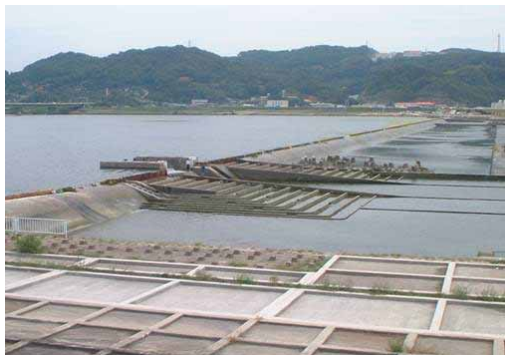
魚道現況(潮止堰の例)
