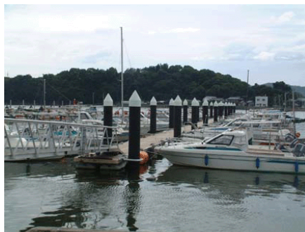
小型船舶係留施設(乙島地区) (岡山県管理・収容 158 隻)
