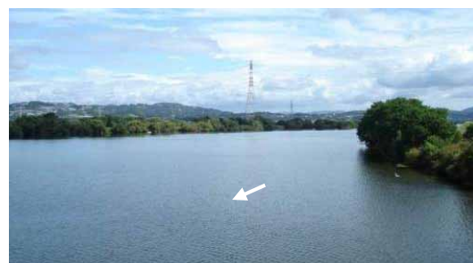
高梁川 潮止堰上流の湛水区間
