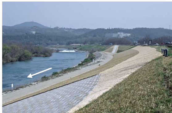
堤防補強の状況（高梁川酒津地区）
