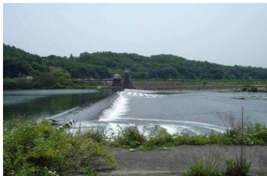
魚道現況(高梁川合同堰(湛井堰)の例)
