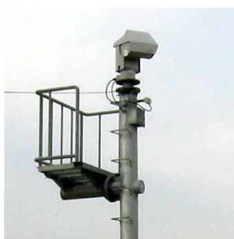
河川監視カメラ
