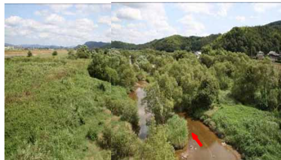
樹林化の現状 (小田川矢形橋付近、平成 19 年)
