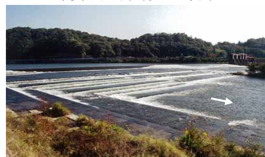
高梁川 高梁川合同堰(湛井堰)の階段式魚道
