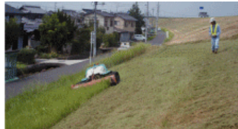
堤防の除草状況
