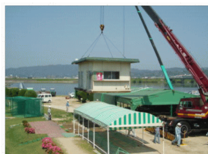
霞橋ゴルフ場上屋の撤去訓練
