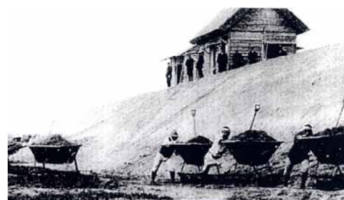
酒津付近の築堤工事(明治44年)
