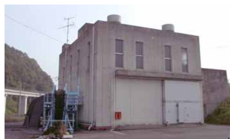
軽部排水機場
