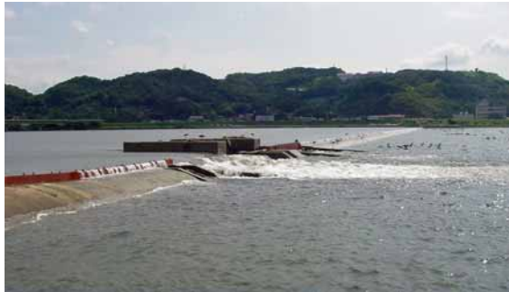
潮止堰の魚道の現状
