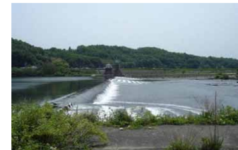
魚道現況(高梁川合同堰(湛井堰)の例)
