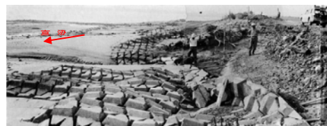
高梁川の護岸被災状況(昭和47年7月洪水)
