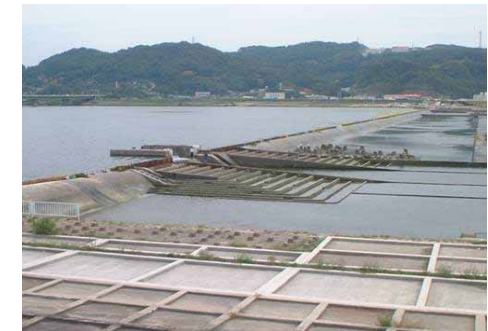
魚道現況(潮止堰の例)
