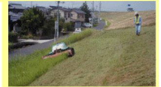
堤防の除草状況
