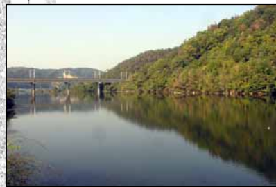
高梁川派川の現状(柳井原貯水池)
