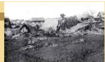
▲家屋の被災状況(真備町川辺)
