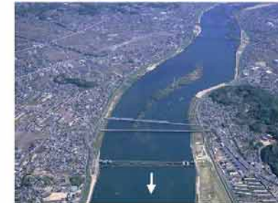
高梁川 潮止堰上流
