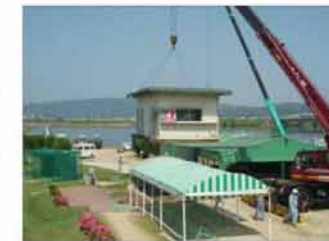
霞橋ゴルフ場上屋の撤去訓練
