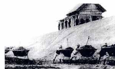
酒津付近の築堤工事(明治 44 年)
