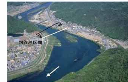
高梁川 国管理区間の上流端付近
