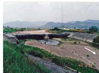
平成6年渇水における小田川の瀬切れ(宮田堰)
