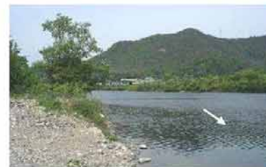
高梁川 湛井堰上流の湛水区間 (国管理区間上流端の下流側)
