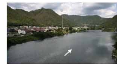
高梁川 国管理区間の上流端付近
