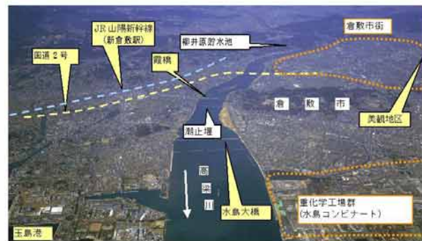
倉敷市と高梁川下流部の状況
