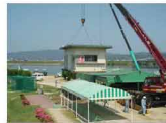
霞橋ゴルフ場上屋の撤去訓練
