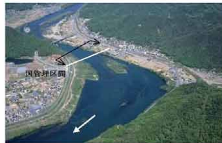
高梁川 国管理区間の上流端付近
