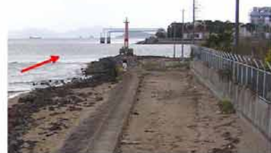
堤防の未整備区間の状況(高梁川河口付近)
