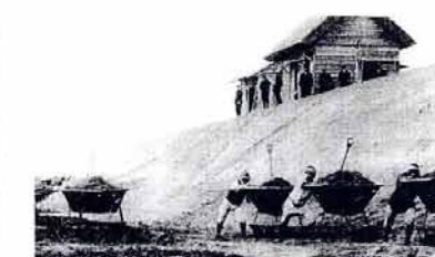
酒津付近の築堤工事(明治 44 年)
