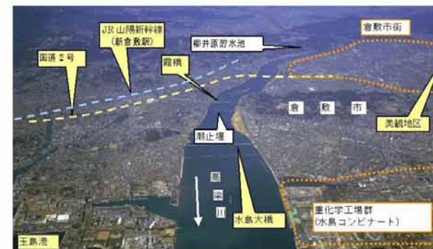
倉敷市と高梁川下流部の状況
