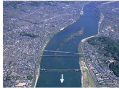
高梁川 潮止堰上流
