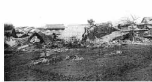
位置：倉敷市真備町川辺字辻尾 出典：岡山縣水害写真帖（明治 26 年） 高梁川の家屋被災状況（明治 26 年 10 月洪水）
