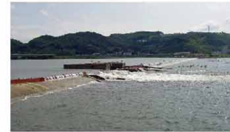
潮止堰の魚道の現状
