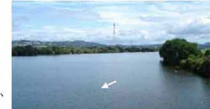
高梁川 潮止堰上流の湛水区間
