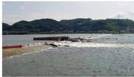
潮止堰の魚道の現状
