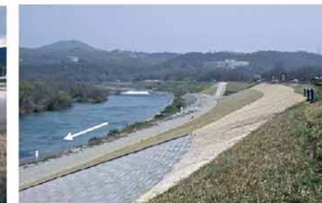
堤防補強の状況（高梁川酒津地区）
