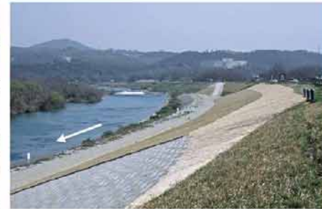
堤防補強の状況（高梁川酒津地区）
