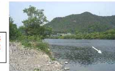
高梁川 湛井堰上流の湛水区間 (国管理区間上流端の下流側)
