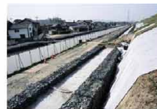
堤防補強におけるドレーン部の施工状況(高梁川10.2k左岸側、倉敷市酒津地先)
