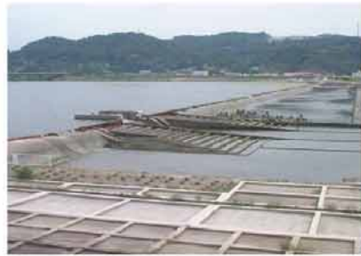
魚道現況(潮止堰の例)
