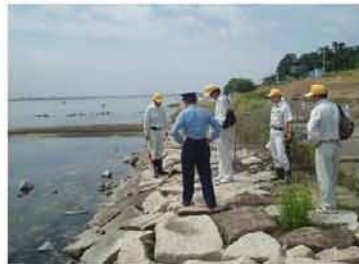
共同安全利用点検の状況（高梁川）
