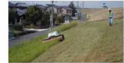
堤防の除草状況
