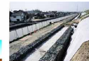
堤防補強におけるドレーン部の施工状況(高梁川10.2k左岸側、倉敷市酒津地先)
