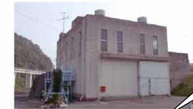
軽部排水機場(ポンプ場)
