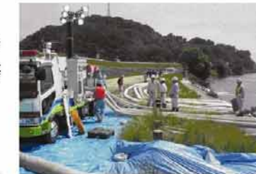
排水ポンプ車操作訓練(高梁川)
