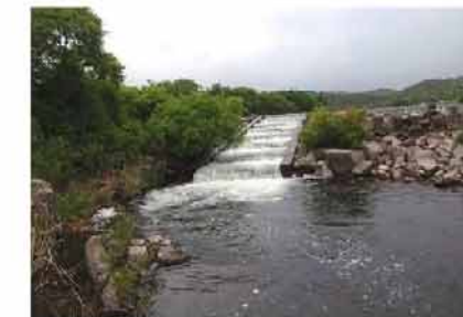
魚道現況(笠井堰)
