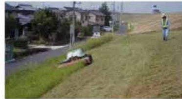
堤防の除草状況
