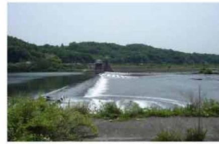
魚道現況(高梁川合同堰(湛井堰)の例)
