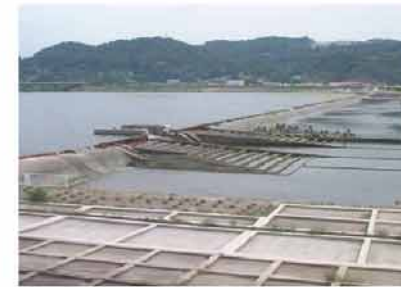
魚道現況(潮止堰)
