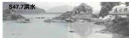
小田川の堤防決壊による浸水状況
