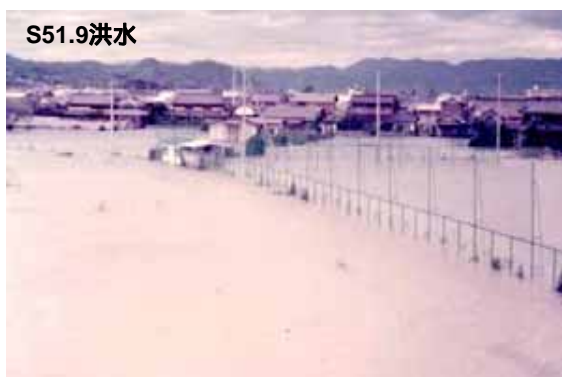
小田川の内水はん濫状況
