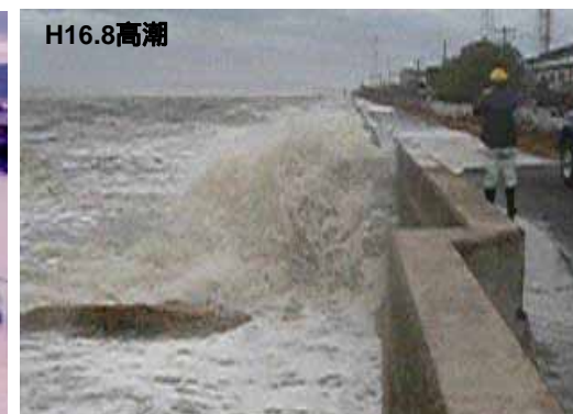
高梁川の高潮越波状況
