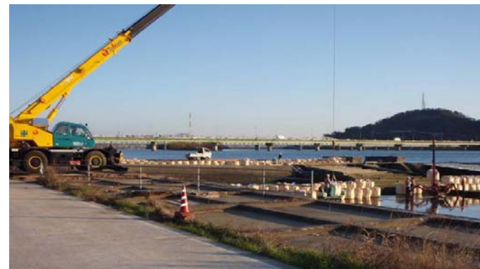
【現地での大型土のう設置状況】
