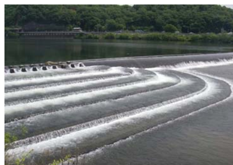
高梁川合同堰(湛井堰)魚道
