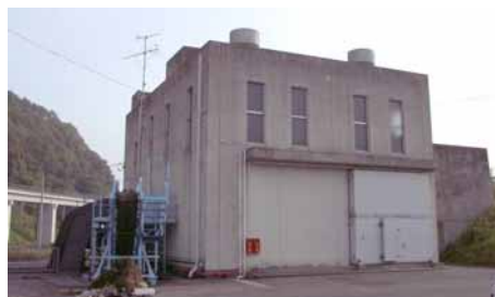
軽部排水機場(ポンプ場)
