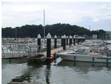
小型船舶係留施設(乙島地区) (岡山県管理・収容 158 隻)
