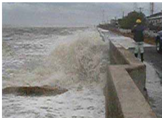
位置：倉敷市玉島乙島地区 高梁川の高潮越波状況（平成16年台風16号）
