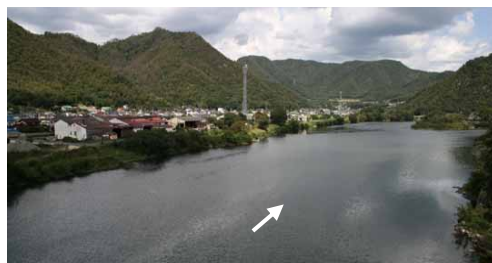
高梁川 国管理区間の上流端付近
