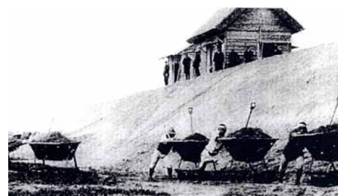
酒津付近の築堤工事(明治44年)
