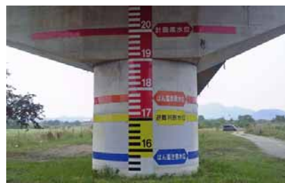
橋脚への量水標の設置状況 (高梁川)
