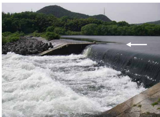
笠井堰(固定堰)
