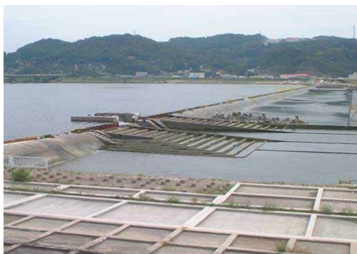
魚道現況(潮止堰)
