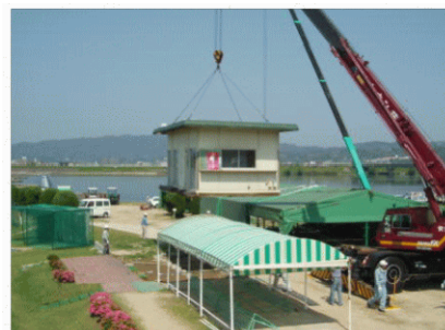
霞橋ゴルフ場上屋の撤去訓練
