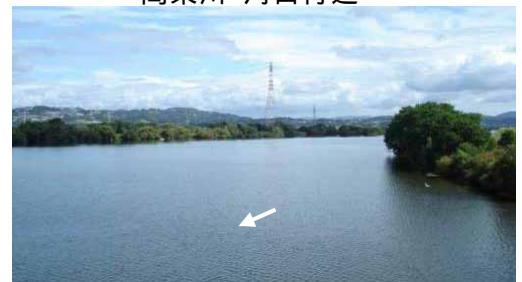
高梁川 潮止堰上流の湛水区間
