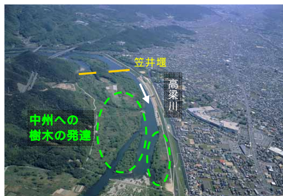
笠井堰付近の樹木の繁茂
