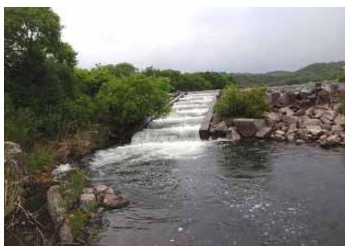
魚道現況(笠井堰)
