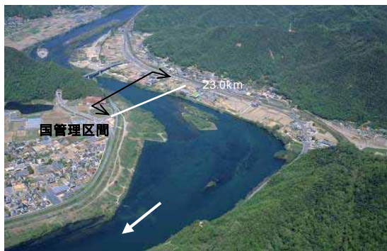
高梁川 国管理区間の上流端付近
