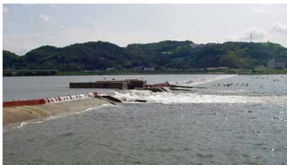
潮止堰の魚道の現状
