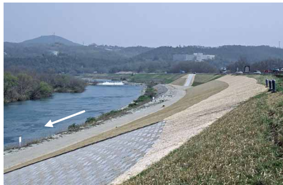
堤防補強の状況（高梁川酒津地区）
